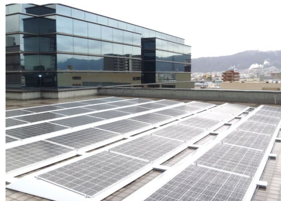
太陽光パネル245kW×42枚(10kW相当)を設置
