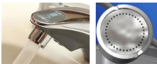
館内の水栓に節水コマを取付け
