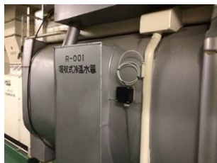
ガス吸収式冷温水機
