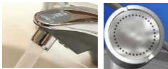
館内の水栓に節水コマを取付け
