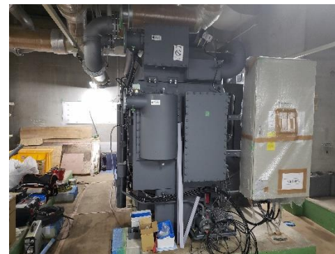
ガス吸収式冷温水機（240USRT）×2
