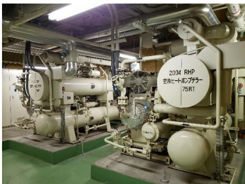
空冷ヒートポンプチラー (75USRT (264kW) ) ×2 (セパレート型)
