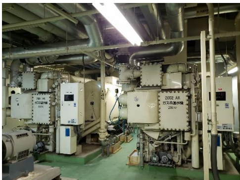
ガス吸収式冷温水機（280USRT）×2
