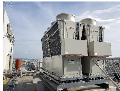
空冷ヒートポンプチラー (180kW) ×4 (モジュール型)
