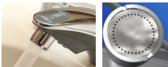
館内の水栓に節水コマを取付け
